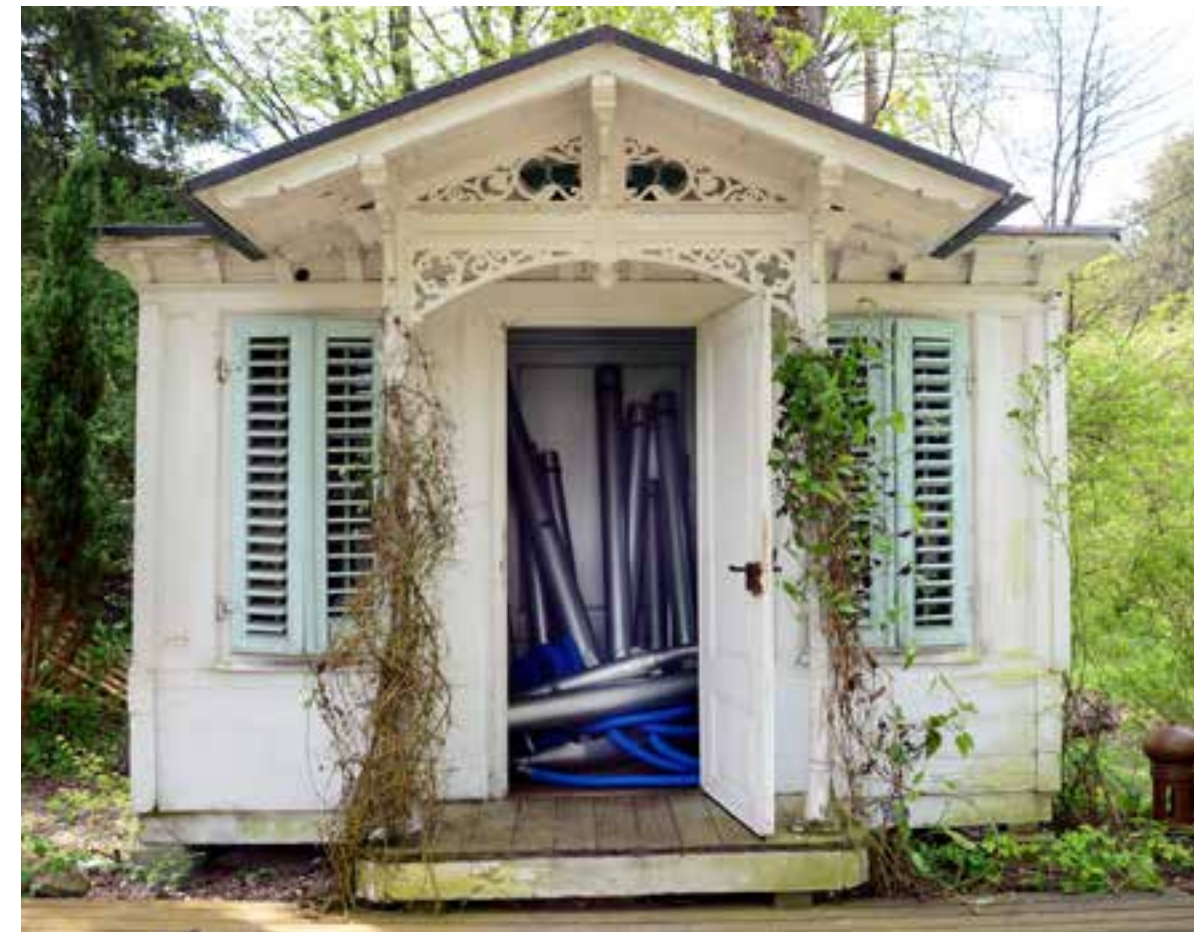
Installation in der Datscha
